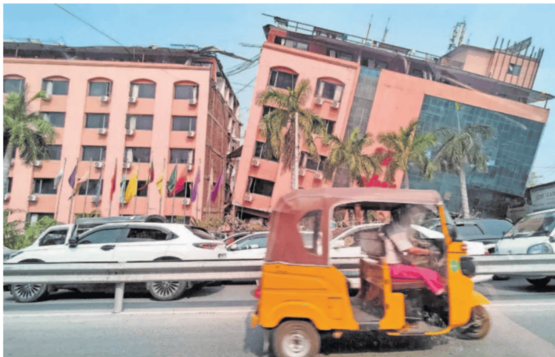
Un edificio dañado en Mandalay (Myanmar) después del fuerte seísmo registrado ayer. REUTERS
