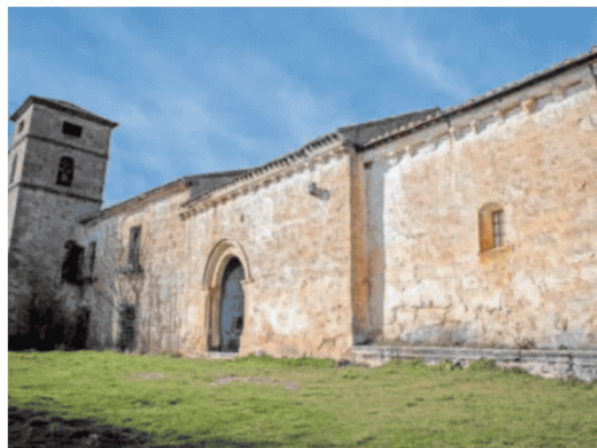
Fachada de la iglesia y la torre del monasterio, en Fuentetoba. M. F.
